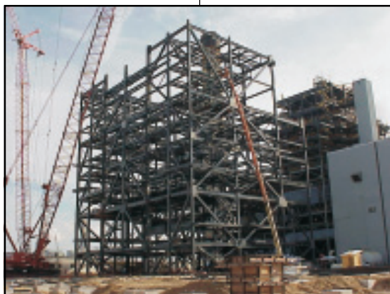
Typical SCR and HRSG steelwork
